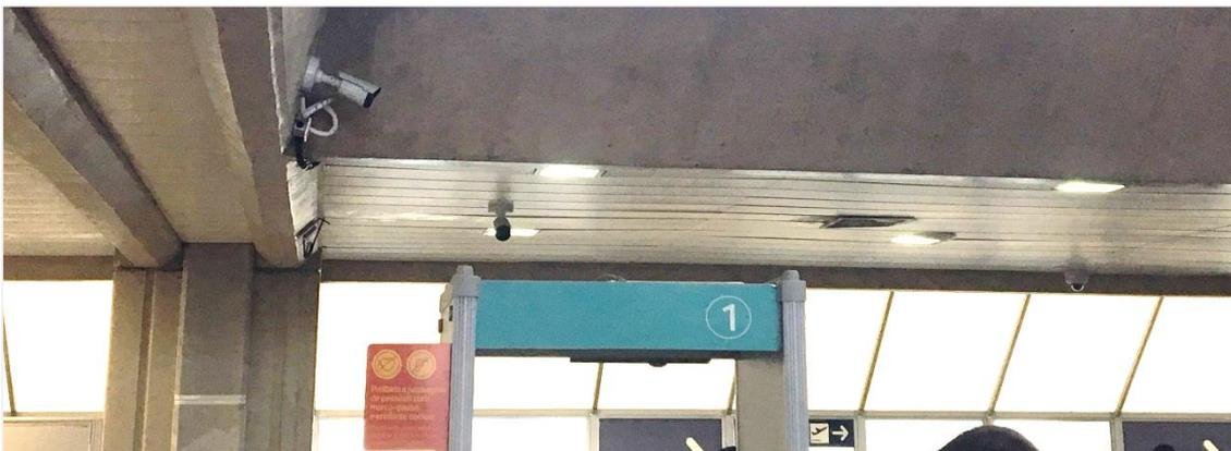
Figura 2-12: Segunda câmera do sistema de cálculo de tempo de fila, localizada de frente para cada pórtico de raio-x do canal de inspeção, no embarque doméstico do Aeroporto Internacional do Rio de Janeiro/Galeão (GIG).
