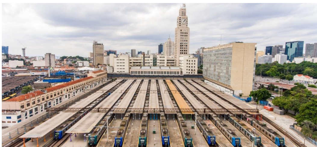
Figura 14 - Estação ferroviária da Central do Brasil Fonte: Supervia (2016).
