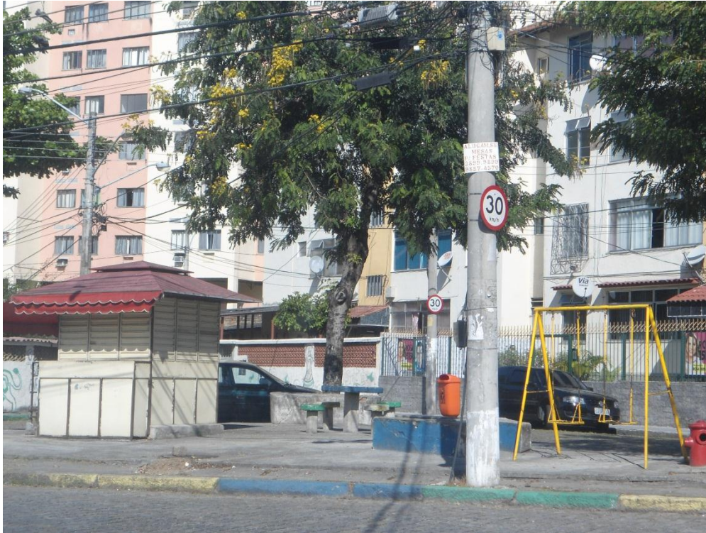
Foto B-5 : R. Fazenda Nova → presença de crianças em áreas de lazer requer uso de medidas moderadoras de tráfego: travessia elevada ou lombadas.
