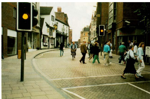
Figura 4.10: Platô utilizado em travessia de pedestres semaforizada, destacando o uso de materiais diferenciados.
