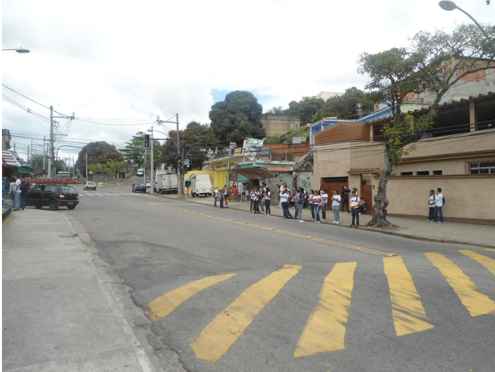
Foto C-5: Estrada do Engenho Novo → o uso de travessia elevada em vez da ondulação transversal proporcionaria maior segurança à travessia.
