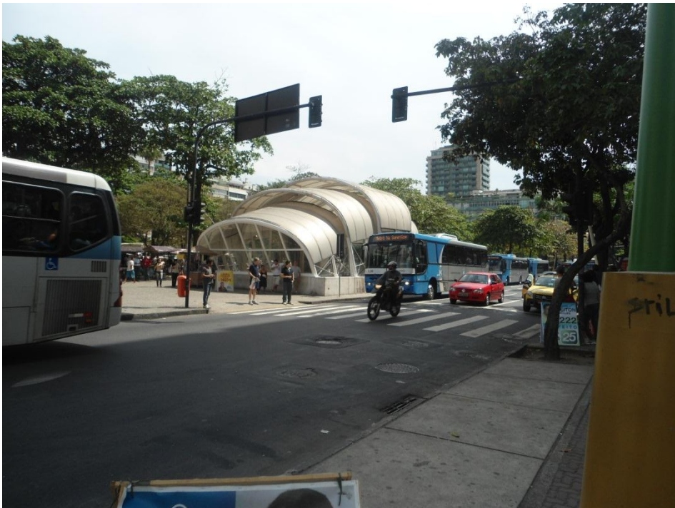
Foto A-2: R. Visc. de Pirajá- Estação do metrô (General Osório) → expressivo volume de tráfego de ônibus das linhas de integração e do BRS.
