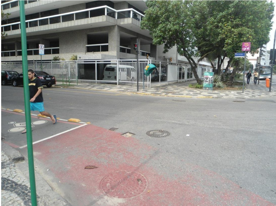
Foto A-5: R. Teixeira de Mello com R. Vieira Souto → travessia com bloco semafórico para pedestres, porém sem pintura da faixa.
