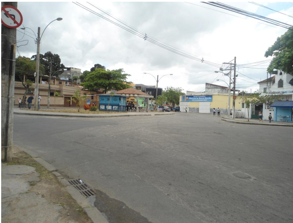
Foto C-4: R. Adolfo Coelho → interseção de 3 vias formando uma área vazia: uso de ilhas de canalização de tráfego serviria como refúgio para os pedestres.
