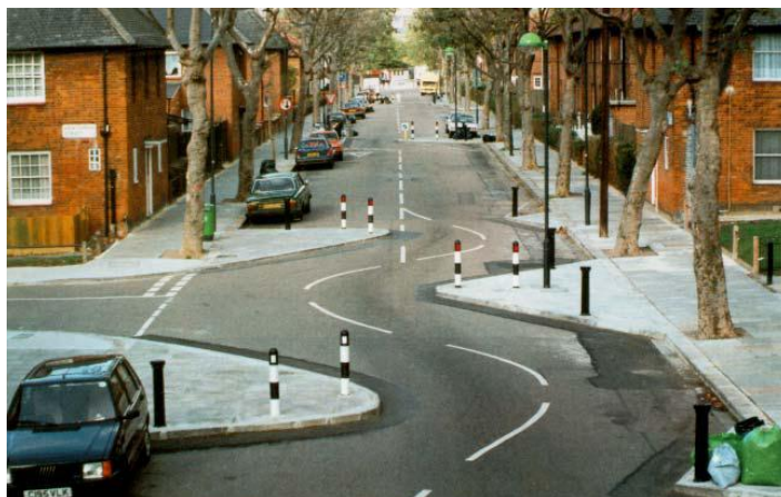
Figura 4.11: Chicana dupla, duas mudanças opostas de direção, em via de mão dupla.
