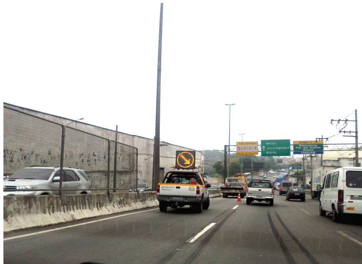
Figura 14: Exemplo de sinalização gráfica luminosa implantada no bloqueio para a faixa reversível na Linha Amarela – Rio de Janeiro.
