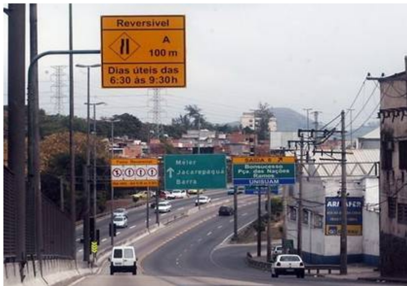
Figura 7: Sinalização gráfica vertical empregada na Linha Amarela – Rio de Janeiro.
