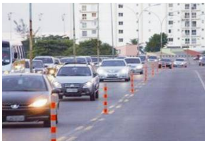
Figura 15: Balizador flexível tubular no Elevado do Joá – Rio de Janeiro.
