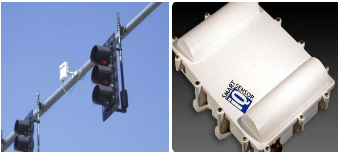
Figura 3.10. Sensores para detecção de velocidade e distância de cada veículo.
