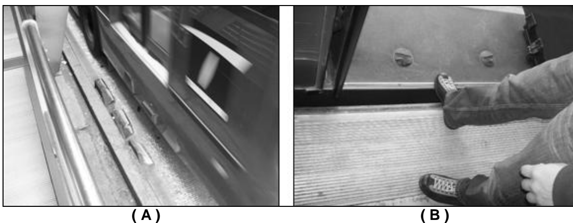
Figura 4.10: Paralelepípedos de Proteção e Distância do Ônibus à Estação (Fonte: Elaboração Própria)
