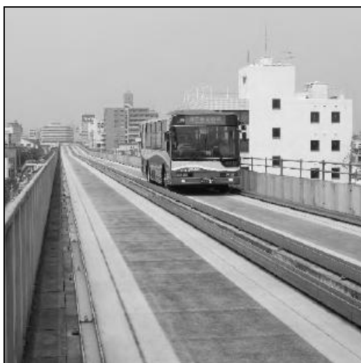
Figura 3.4: Sistema Elevado de BRT: Linha Yutorito em Nagoya (HOOK e WRIGHT, 2007)
