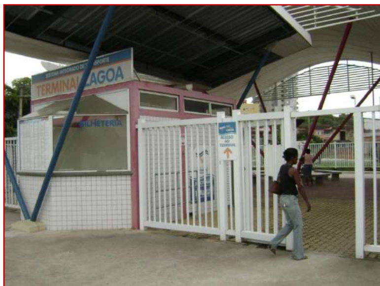
Figura 56 – Fotografia da entrada de usuários ao Terminal Lagoa, com bilheteria desativada e livre acesso ao terminal que funciona atualmente como ponto de parada comum.
