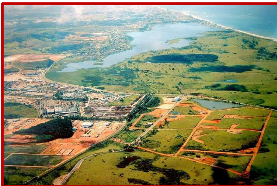
Figura 43 - Vista aérea do loteamento da Zona Especial de Negócios localizada estrategicamente no limite com o município de Macaé, onde se pode observar o Parque de Tubos da Petrobras e a Lagoa de Imboassica à esquerda do loteamento.
