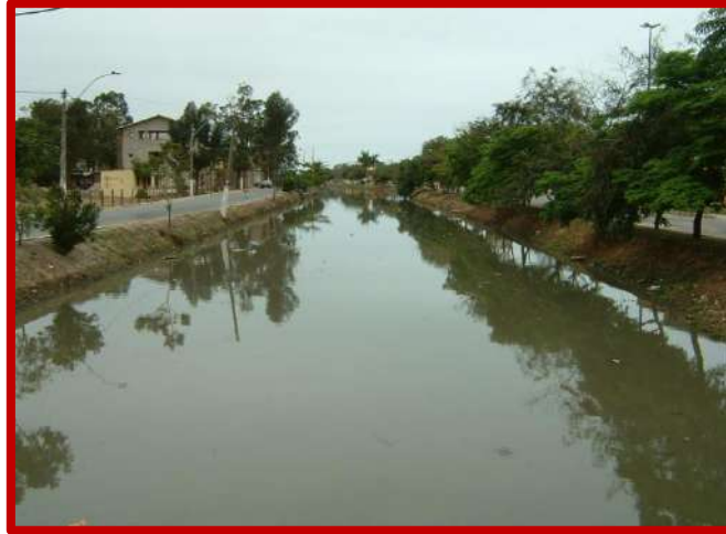
Figura 31 - Canal Macaé - Campos atualmente, no trecho em frente ao Terminal CEHAB, sentido Campos. Foto: Rafael Lucas
