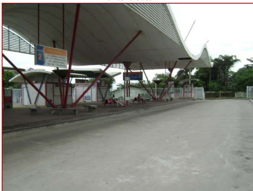
Figura 57 – Fotografia do Terminal Lagoa, movimento pouco expressivo de passageiros no horário de pico da manhã.
