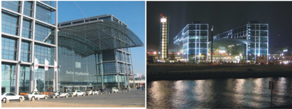
Figuras 10 e 11 – Estação Berlin Hauptbahnhof
